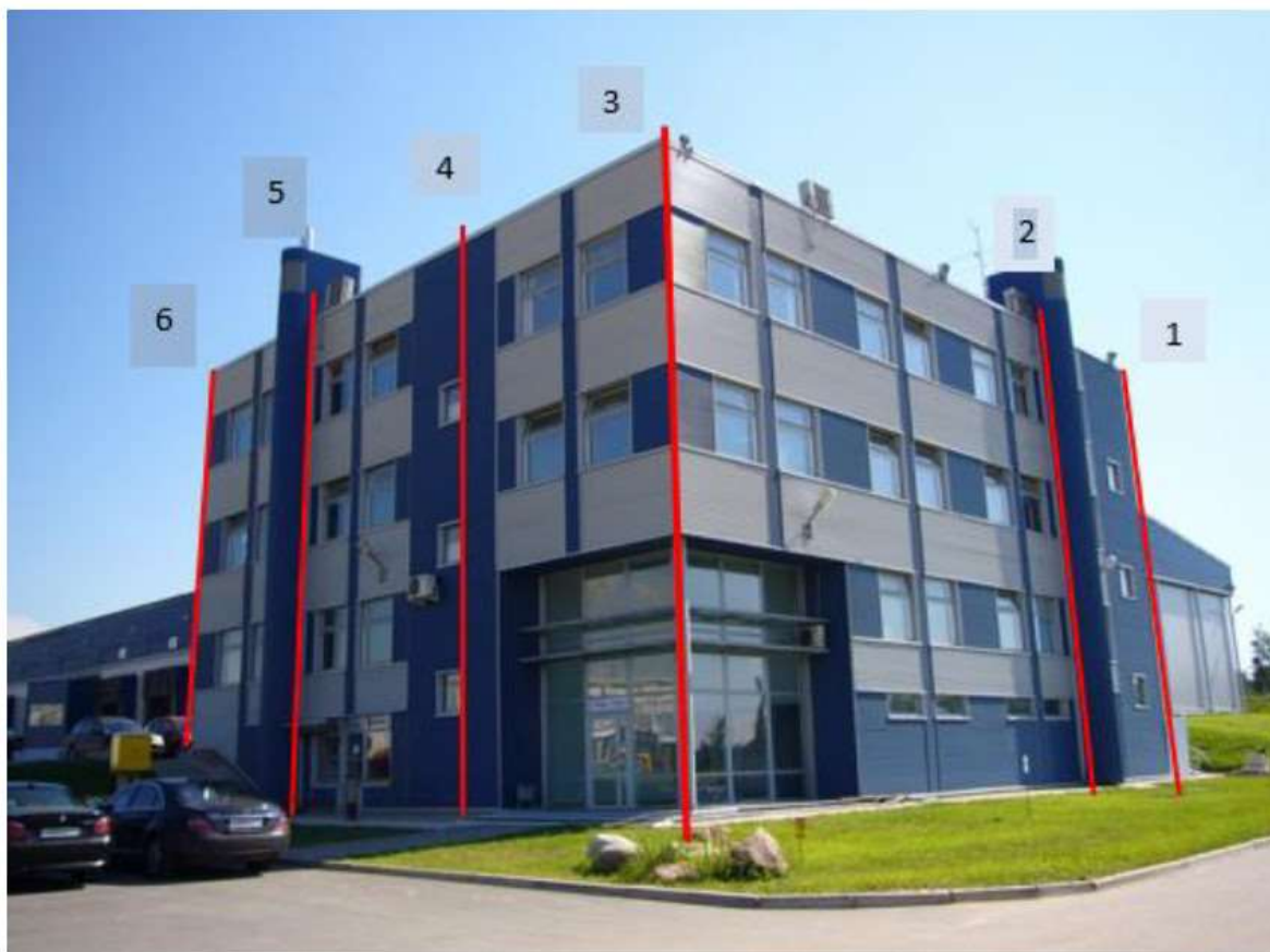
Фото 2.4. Геодезические измерения снаружи здания (красными линиями показаны оси измерения)
