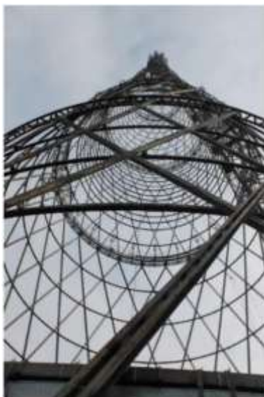
Фото 1.2. Пример башенного сооружения со стальным каркасом
