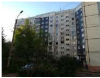
Фото 1.2. Пример типового панельного многоэтажного здания
