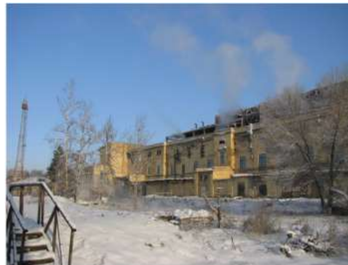
Фото 2. Фасад здания турбинного зала
