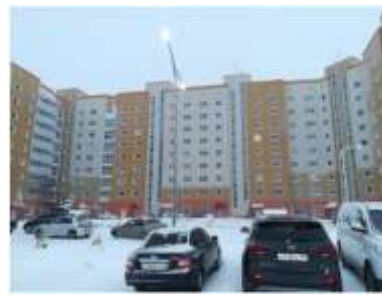
Фото 1.3. Пример типового монолитного многоподъездного железобетонного здания
