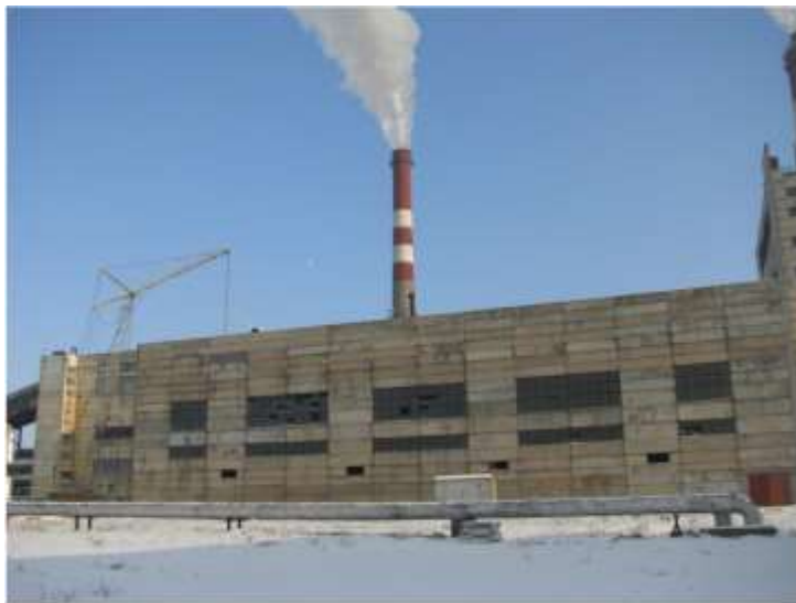
Фото 1. Фасад здания котельной
