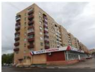
Рис. 1.1. Пример типового кирпичного многоэтажного здания
