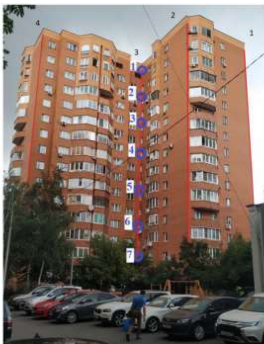
Рис. 2.1. Геодезические измерения снаружи здания (красными линиями показаны оси измерения, а синими кружками - точки измерений)
