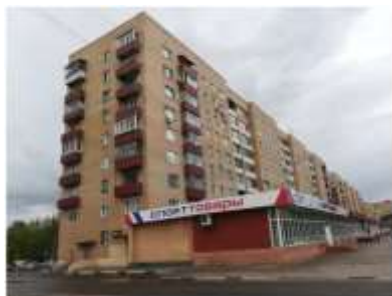
Фото 1.1. Пример типового кирпичного многоэтажного здания
