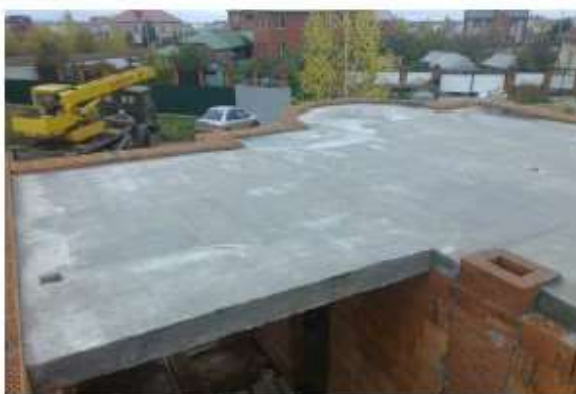
Рисунок 4 - Монолитные железобетонные плиты
